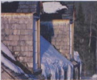
Cambiar el aislamiento es una reforma común
