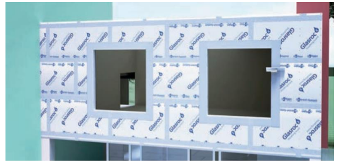
Figura 6.3: Placa exterior Glasroc® X y su tratamiento de juntas.
