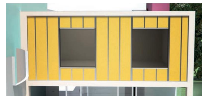
Figura 6.2: Panel aislante en las cavidades de la subestructura.
