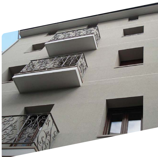
Rehabilitación de edificio con Placotherm V
