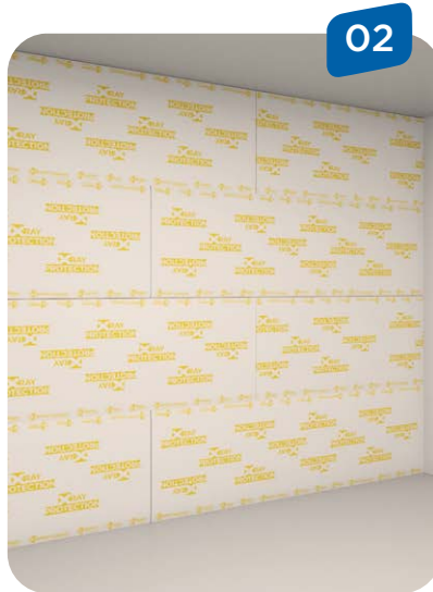
Placas instaladas en horizontal
