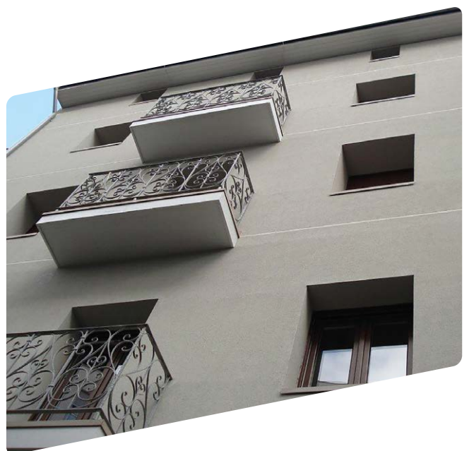
Rehabilitación de edificio con Placotherm V
