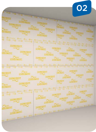
Placas instaladas en horizontal
