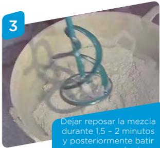
3 Dejar reposar la mezcla durante 1,5 - 2 minutos y posteriormente batir a mano o a máquina energicamente hasta conseguir una pasta homogénea.
