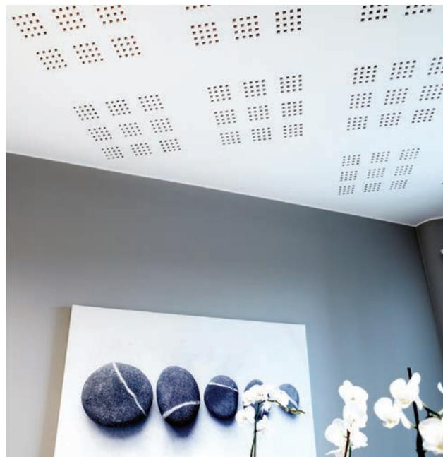
Techos continuos suspendidos de estructura simple bajo losa de hormigón de 140 mm de espesor.
