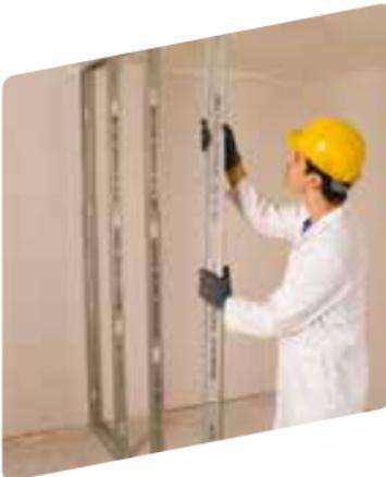
La capa exterior se atornilla a todos los montantes de la estructura metálica con distancias entre tornillos de 300 mm como máximo, reduciéndose a 200 mm en el perímetro de las placas.
