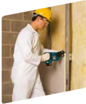
Todas las juntas de las placas deberán estar contrapeadas, tanto entre capas de placas de una misma cara, como entre ambas caras del tabique. En los tabiques de dos o más placas las juntas horizontales y verticales se alternarán evitando así la coincidencia entre las capas.
