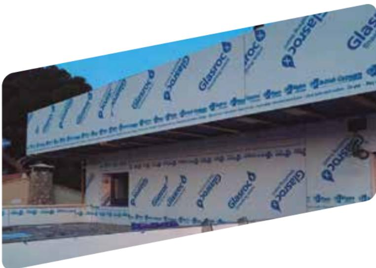
Para el atornillado de las placas a los montantes THM, se emplearán tornillos **Placotherm® Integra** de longitud 25 mm. En la instalación deberá asegurarse que no se rompen o perfora el revestimiento exterior de las placas. La separación entre tornillos será de 150 mm máximo y a 15 mm del borde de las placas realizándose el atornillado en zig-zag a lo largo de las juntas entre placas.
