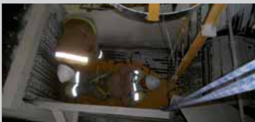
Evacuación del accidentado
