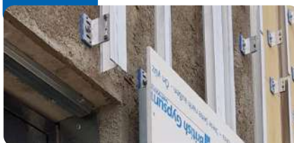
Instalación de la placa
