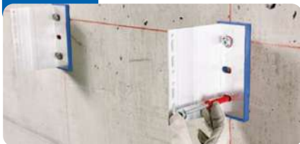
Colocación de ménsulas de sujeción y retención
