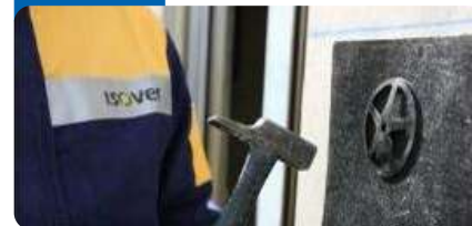
Colocación de aislamiento
