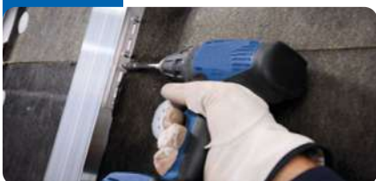
Colocación de perfiles T y L
