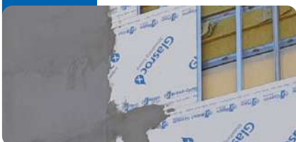
Aplicación capa de regularización
