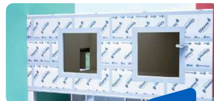
TRATAMIENTO DE JUNTAS CON PLACOTHERM® BASE
