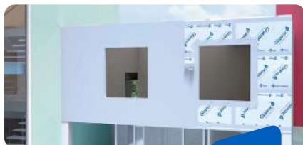
APLICACIÓN DE MORTERO PARA CAPA DE REGULARIZACIÓN
