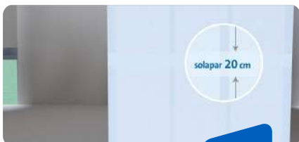
COLOCACIÓN LÁMINA IMPERMEABLE
