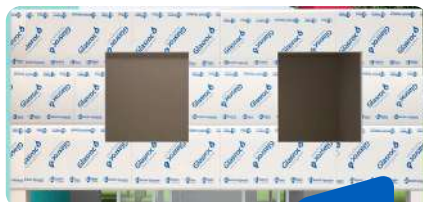
COLOCACIÓN PLACA EXTERIOR GLASROC® X / AQUAROC®
