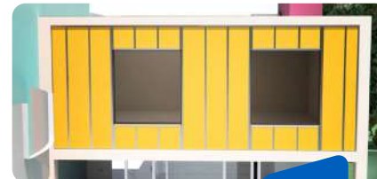
COLOCACIÓN AISLAMIENTO ARENA APTA EN LA HOJA EXTERIOR
