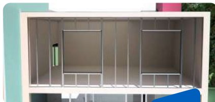
INSTALACIÓN ESTRUCTURA THM Y THR PARA HOJA EXTERIOR
