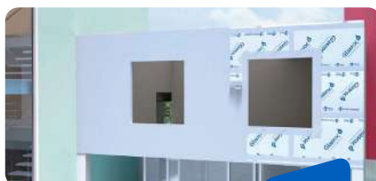
APLICACIÓN DE MORTERO PARA CAPA DE REGULARIZACIÓN
