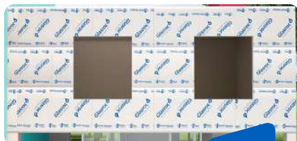
COLOCACIÓN PLACA EXTERIOR GLASROC® X / AQUAROC®
