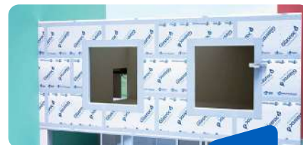
TRATAMIENTO DE JUNTAS CON PLACOTHERM® BASE
