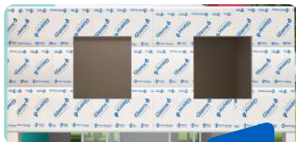
COLOCACIÓN PLACA EXTERIOR GLASROC® X / AQUAROC®
