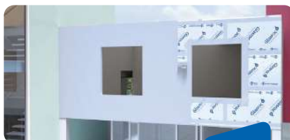
APLICACIÓN DE MORTERO PARA CAPA DE REGULARIZACIÓN
