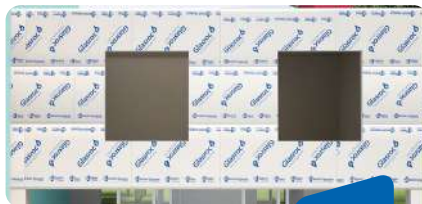
COLOCACIÓN PLACA EXTERIOR GLASROC® X / AQUAROC®
